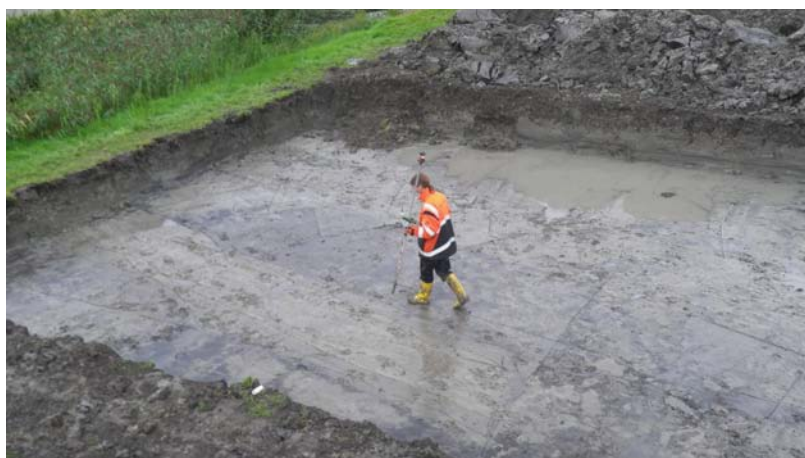
Afb. 2.1 Het inmeten van greppels met de robotic Total Station.
